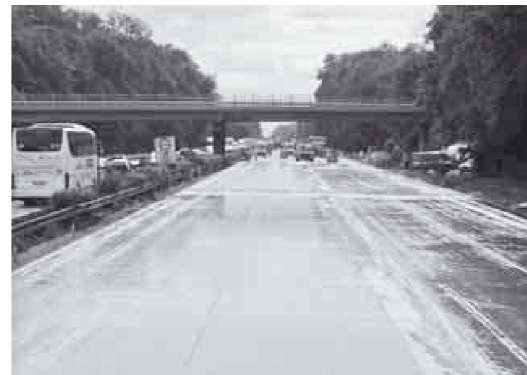
Obrázek 3: Beton pokrytý fólií
