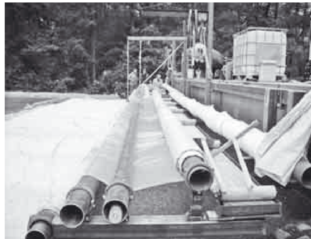
Obrázek 6: Pracovní lávka – zařízení pro aplikaci fólie
