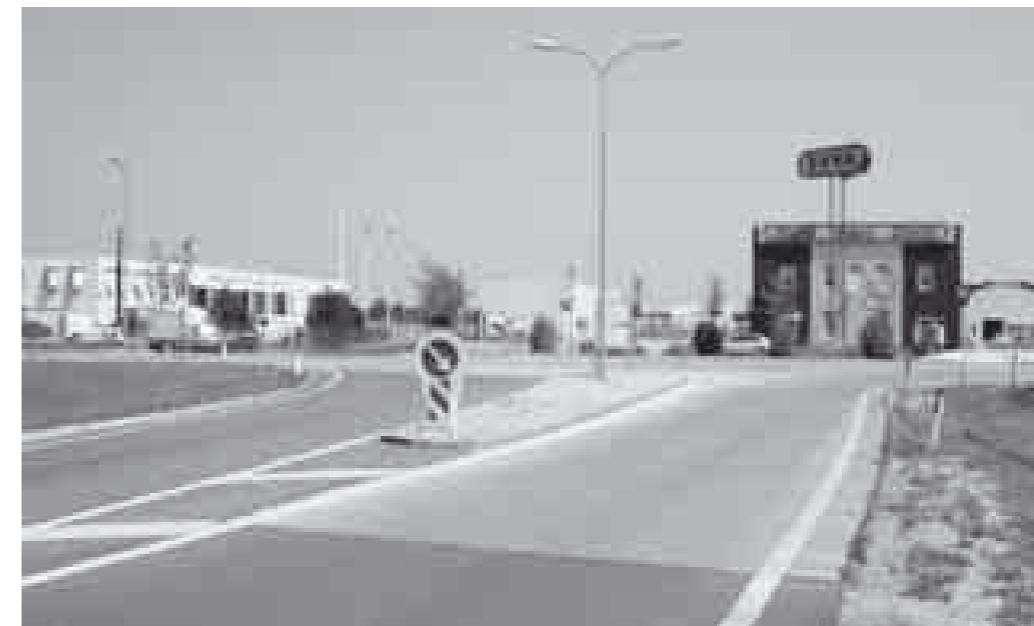
Abbildung 4: Kreisverkehr in Bad Fischau / N.Ö., nur die Einfahrt in Beton [3]
