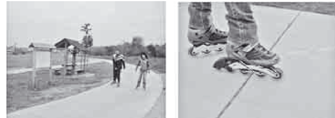
Betonový povrch je oblíben zejména mezi uživateli kolečkových bruslí a přesně provedená příčná dilatační spára se záhlvkou není při jízdě téměř znatelná
