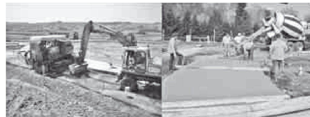
Obrázek 5: Pokládka betonu finišerem [3]
