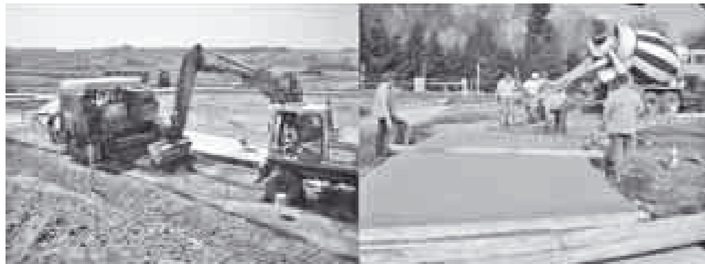
Abb. 5: Betoneinbau mit Fertiger [3]
