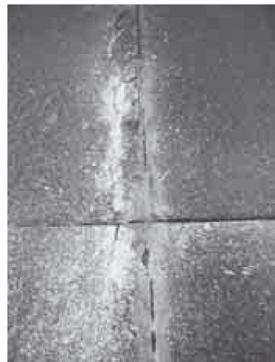
Obr.5 : TWY F – Detail v okolí spáry (stav v 04/2008) foto: autor
