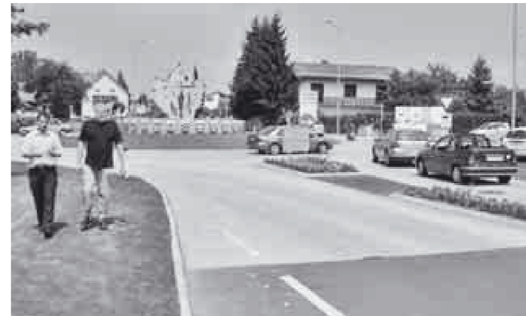
Abbildung 3: Kreisverkehr Kaindorf / Steiermark, Ein- und Ausfahrt in Beton [3]
