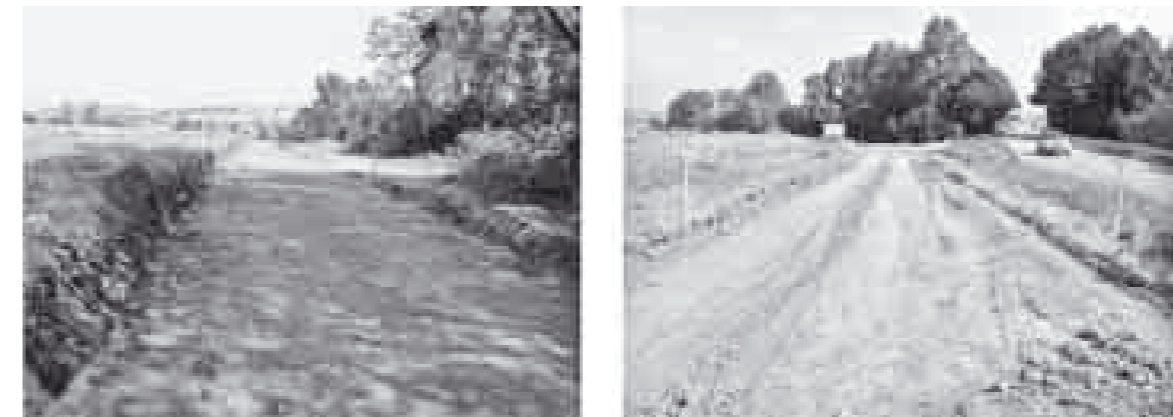
Cyklostezka z Uherského Brodu do Nivnice bude ukončena v listopadu 2008
