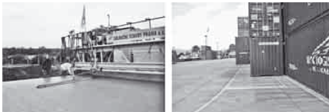
Obr. 1: Betonáž plochy, podélný hladíči vyrovnávající
