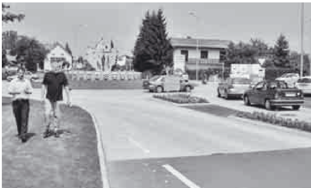
Obrázek 3: Okružní křižovatka Kaindorf / Steiermark, betonový nájezd a výjezd [3]
